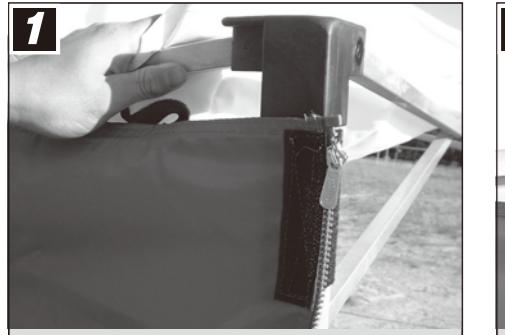
本体柱部の天幕を外し、フレームの柱に付いているマジックテープと横幕内面に付いているマジックテープを重ね合わせて貼り付けます。
